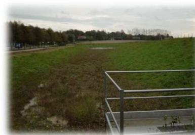
Bassins de rétention
